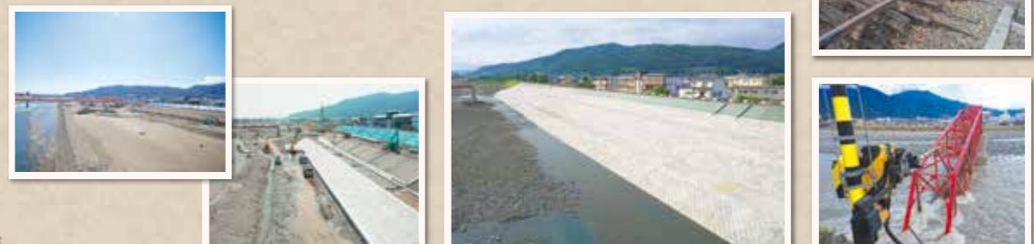
2020年3月(左)と4月(中)の工事の様子。堤防の復旧作業が完了(右)して3段構造となり、強固になる。災害から2日後の様子
